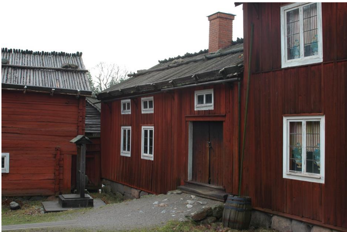
Fäxet ligger i vinkel mot logen och ihopbyggd med Sängstugan på Delsbogården. Bilden är tagen innan åtgärder.
